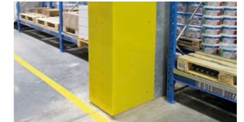
Anfahrerschutz für Betonpfeiler
